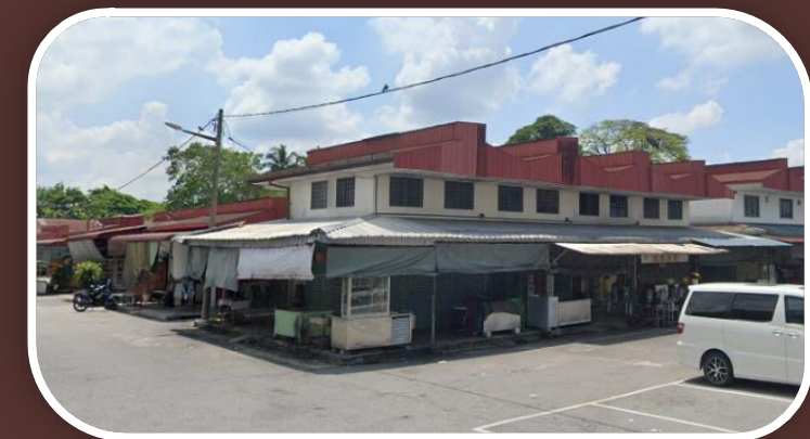
Rajah 3.15: Pasar pagi Bidor berpotensi untuk dihubungkan dengan jaringan pejalan kaki ke destinasi seperti Sungai Bidor, Petai Lane dan hentian bas lama Bidor yang boleh menguatkan kesinambungan jaringan pejalan kaki di Bandar Bidor. Sumber: PIL MD Tapah 2035
